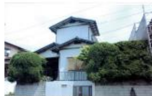
戸建てリフォーム例(外観)
